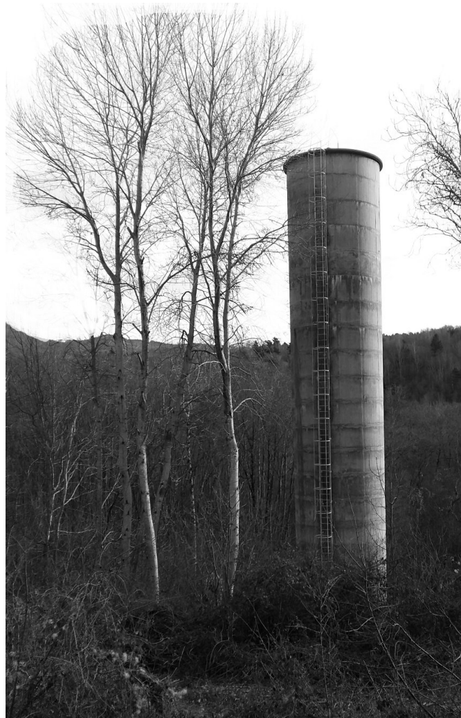
FIGURE 7.11 : Cheminée d'équilibre en béton de la centrale hydroélectrique de la Trinité (Hautes-Alpes). (photo prise par S. ALLEC).
